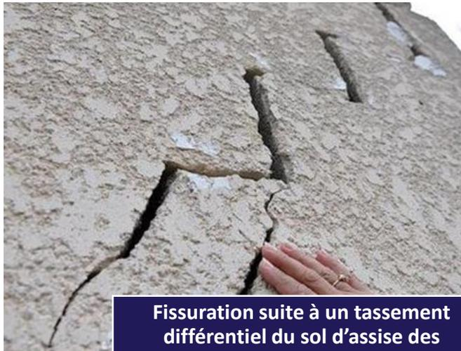
Fissuration suite à un tassement différentiel du sol d'assise des fondations superficielles
