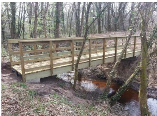
Réalisation d'une passerelle bois sur le site des Lacs au printemps 2014 (portée 8,50 m, largeur 1,40 m et hauteur maxi. 2,00 m) :
