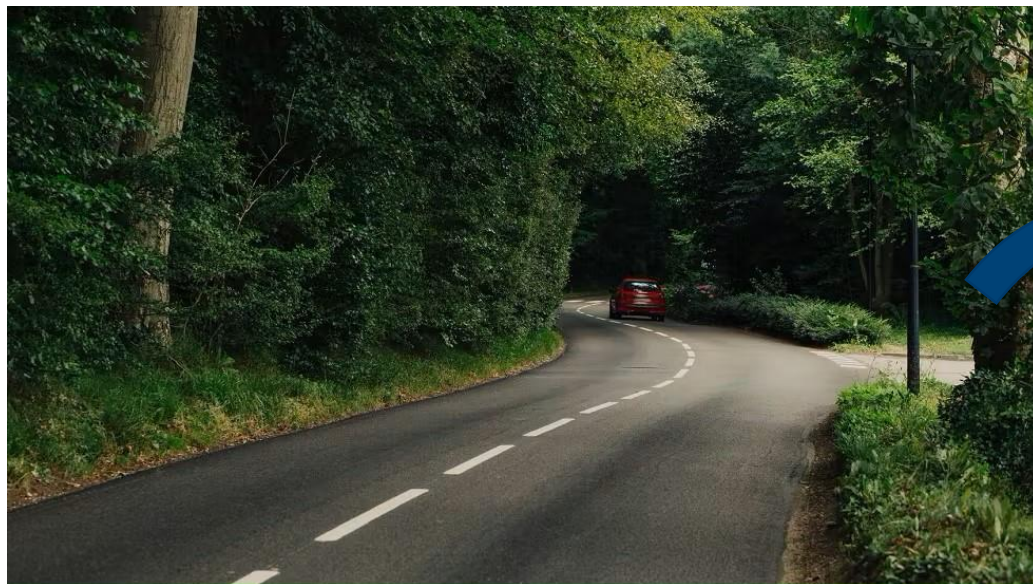
Chaussée initiale à deux voies de circulation automobile
