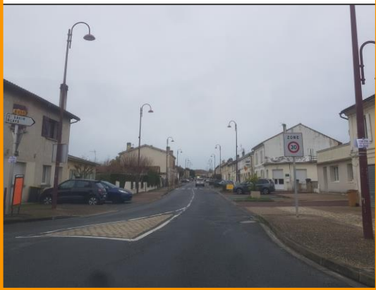
Entrée de la Zone 30 non matérialisée suivie de ralentisseurs
