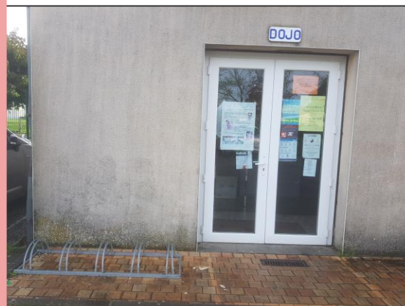
Stade – rue du 11 Novembre - Cézac
