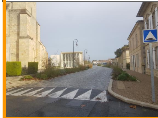
Transformer la route en rue pour casser la vitesse. Zone 30 : l'aménagement du parvis matérialise la limitation de vitesse
