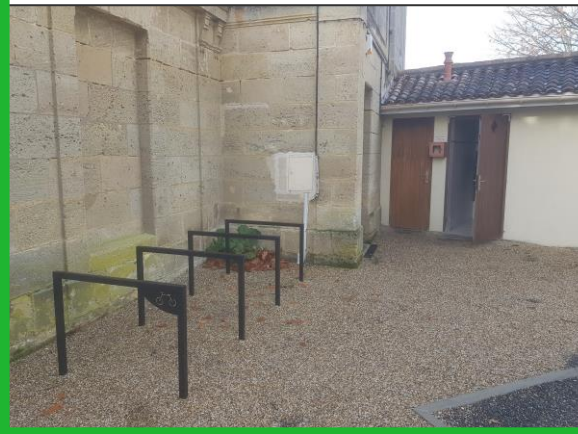
Mairie – rue du 11 Novembre - Cézac
