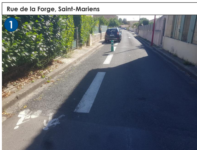
Aménagement non conforme utilisé comme espace de stationnement
