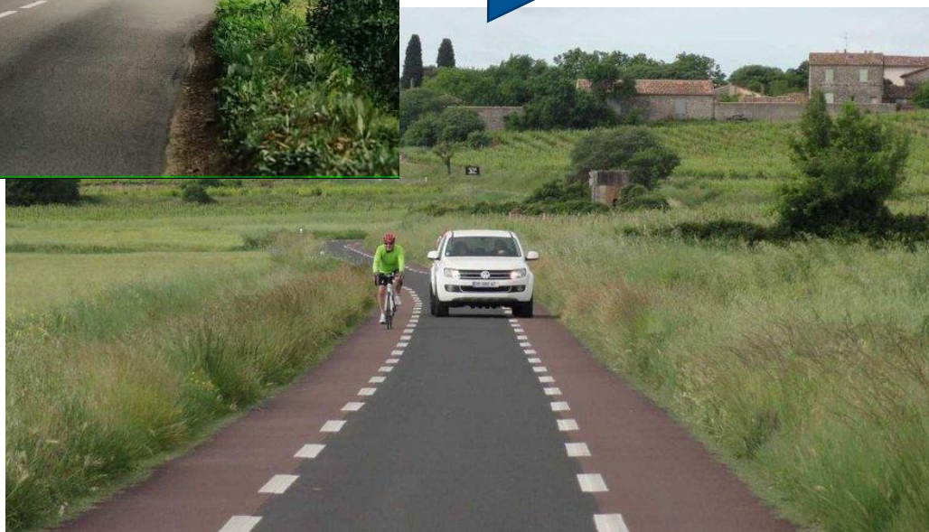
Chaucidou : une voie centrale banalisée bidirectionnelle et deux espaces de circulation dédiés aux modes actifs alors prioritaires.
