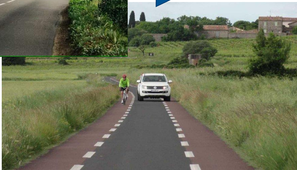
Chaucidou : une voie centrale banalisée bidirectionnelle et deux espaces de circulation dédiés aux modes actifs alors prioritaires.
