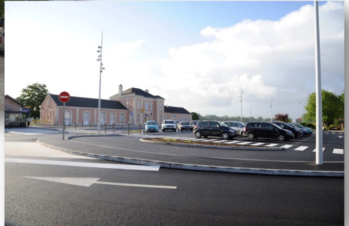
Place du 8 mai 1945 après les travaux
