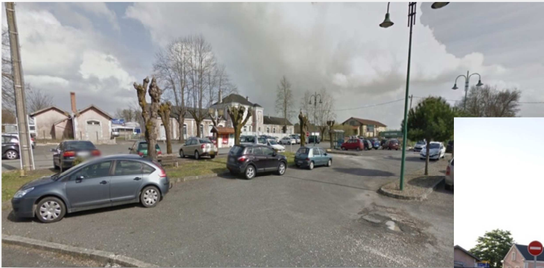
Place du 8 mai 1945 avant les travaux, bâtiment voyageurs en fond d'image.
