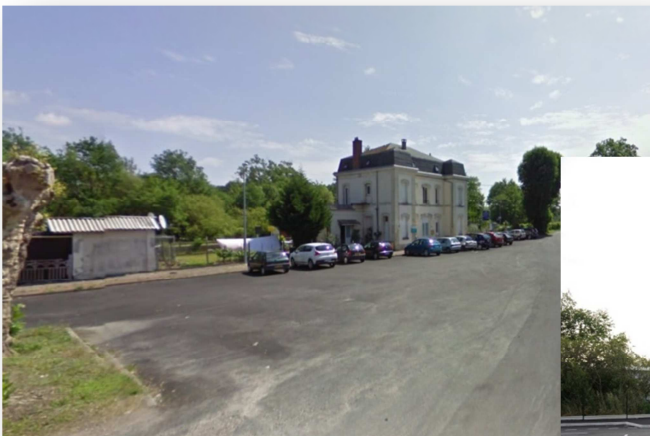
Abords de la halte avant les travaux
